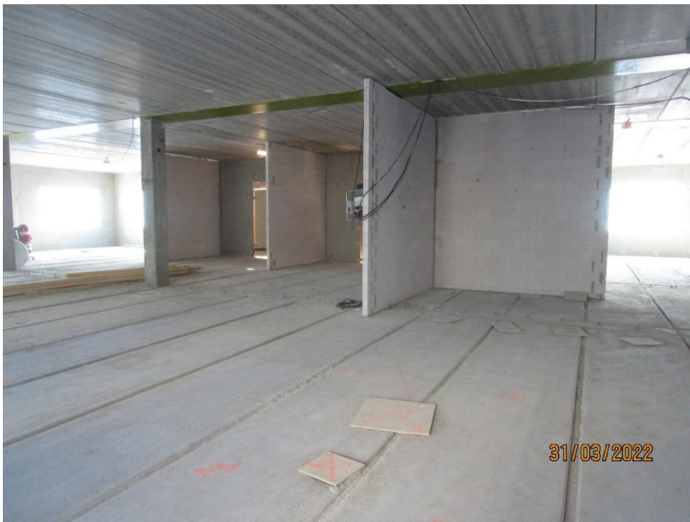
Väliseinämuuraukset päiväkodissa
