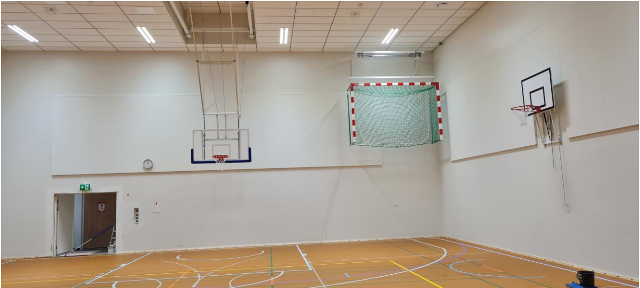
Liikuntasalin välineet asennettuna ja lattia valmis
