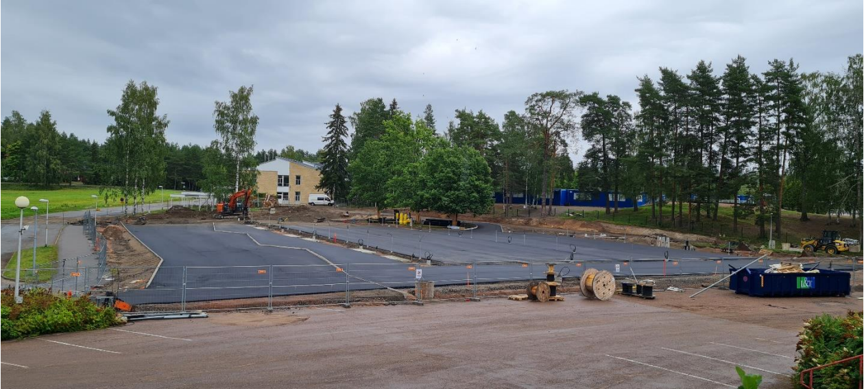
Pohjoispihan P-alue asfaltoituna
