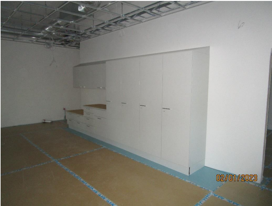
Mallikaluste asennettu tilaan A1.043
