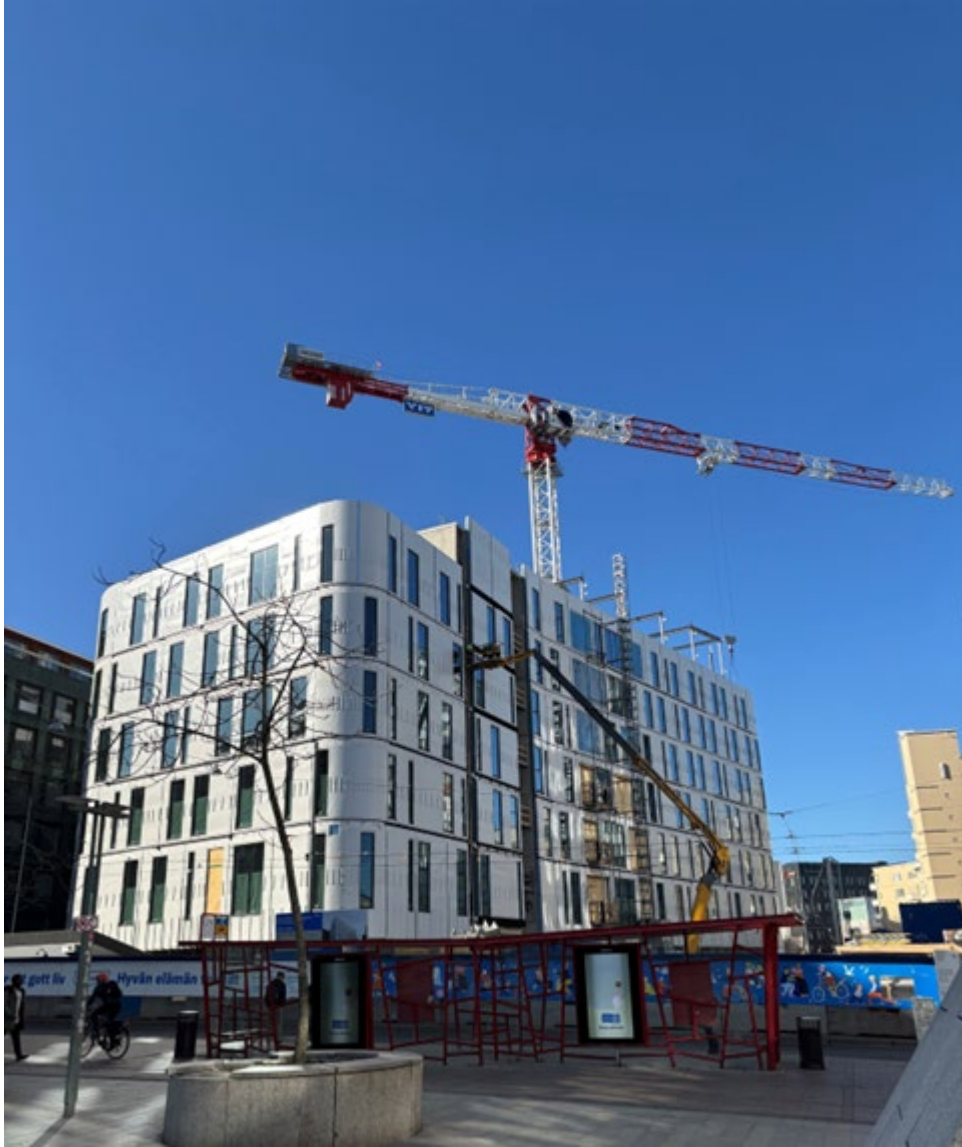
Kuva työmaasta Fredrikinkadulta 15.4.2025
