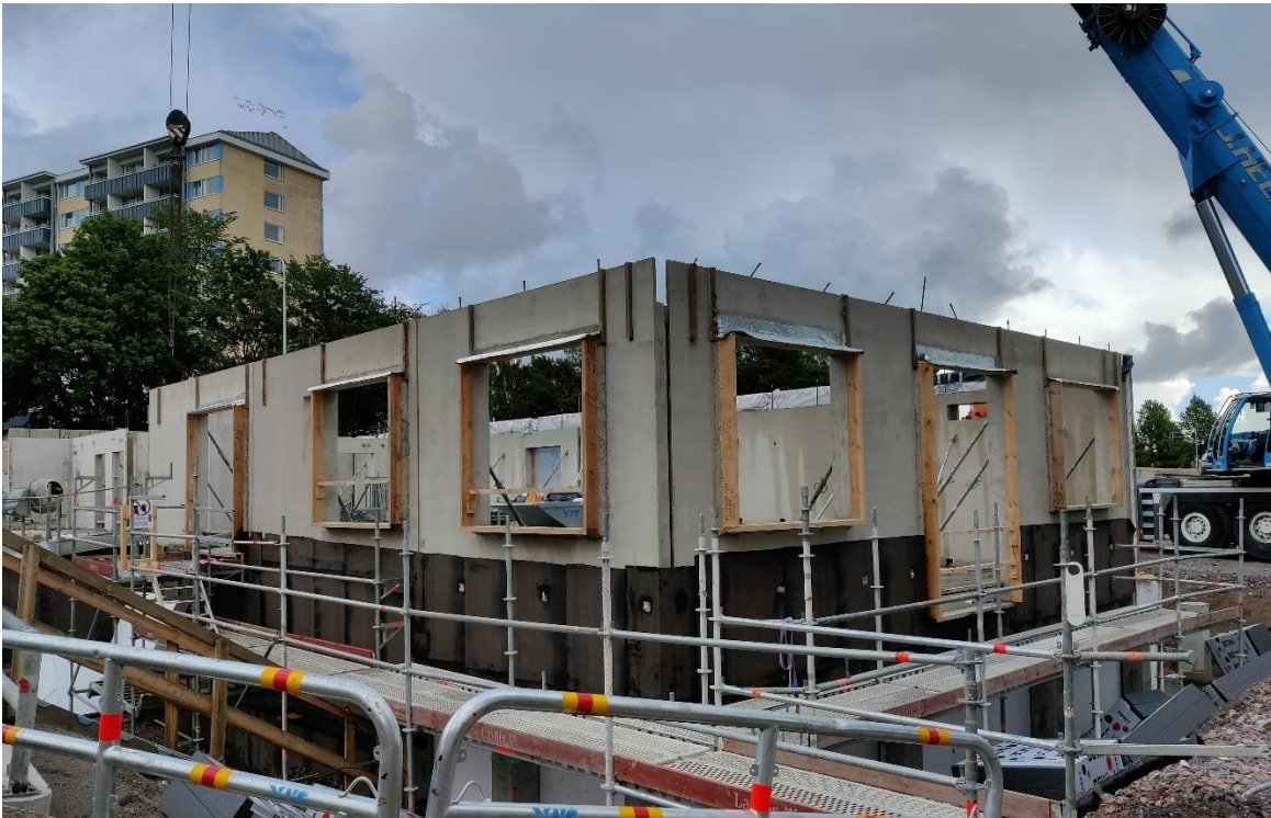
Kuva Hitaksen toisen talon kellarikerroksesta.
