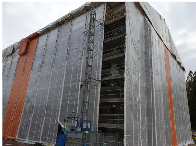
Kuvassa ensimmäisen lohkon sääsuojan asennus aloitettu
