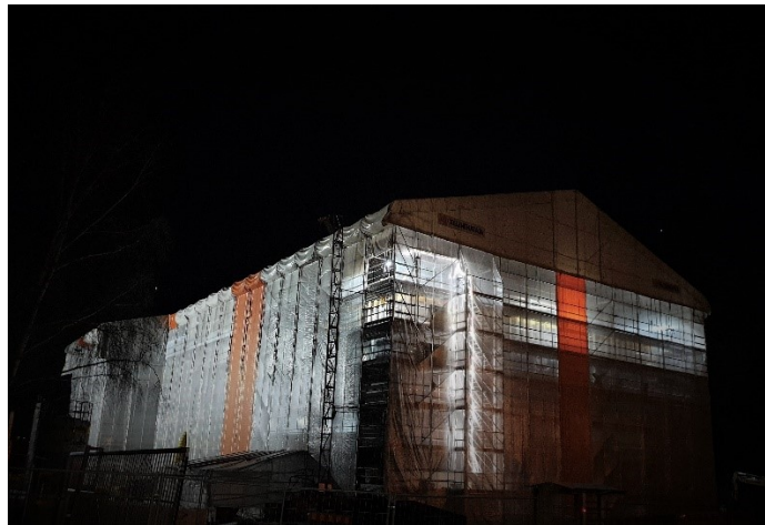
Kuvassa ensimmäinen lohko sääsuojan sisällä
