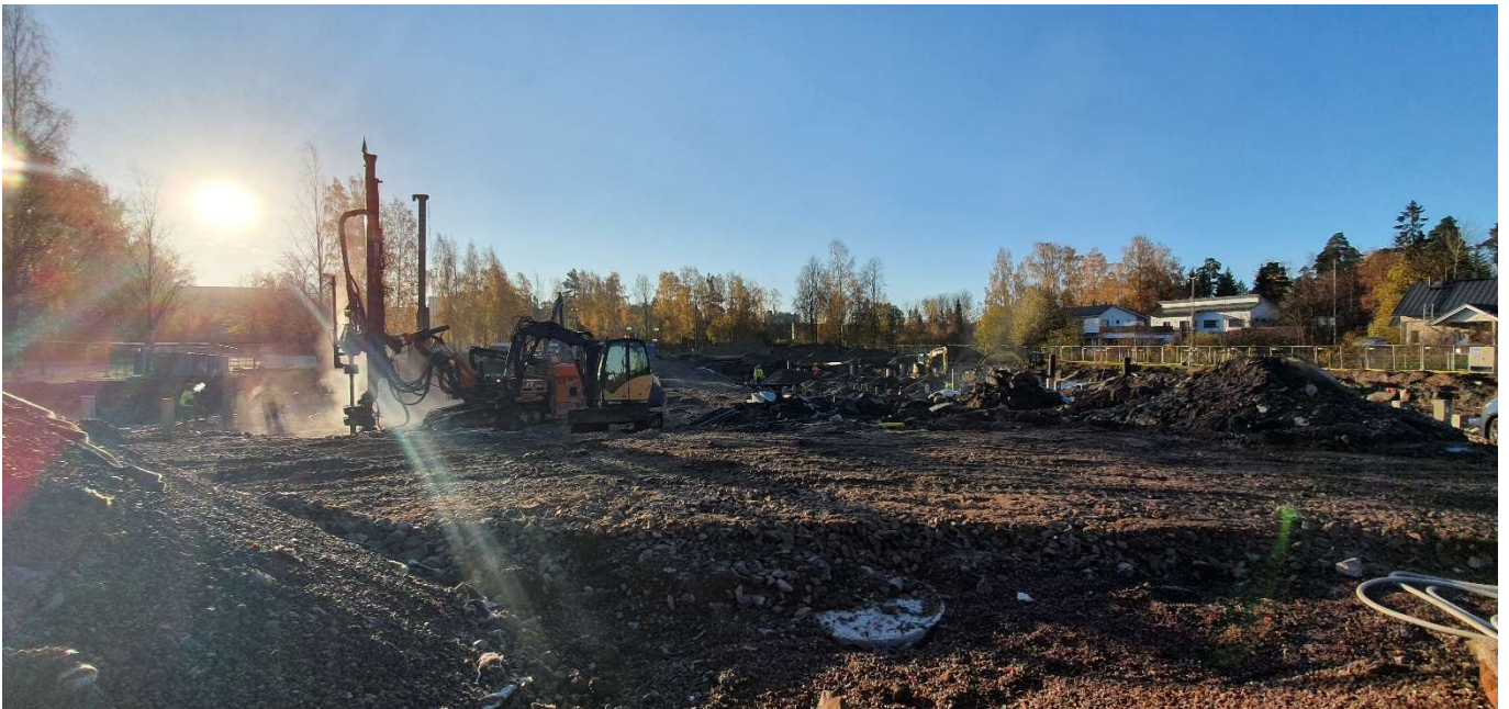
Pora- ja lyöntipaalutustyöt käynnissä.
