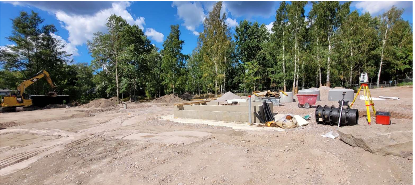
Pihatöiden valmistelut käynnissä.
